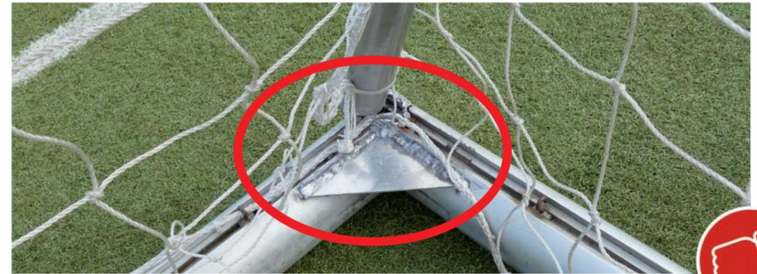
Bild 28: Eingeschweißter Winkel stellt erhöhte Verletzungsgefahr dar
