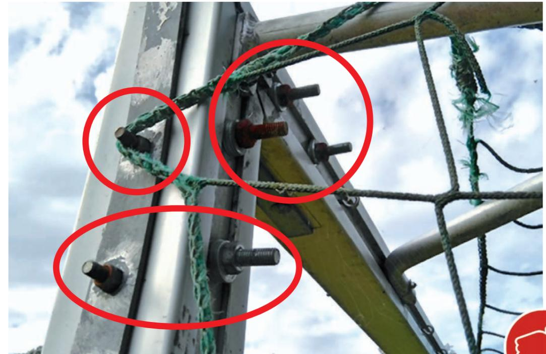
**Bild 17:** Überstehende Schrauben an Pfosten und Querlatte
