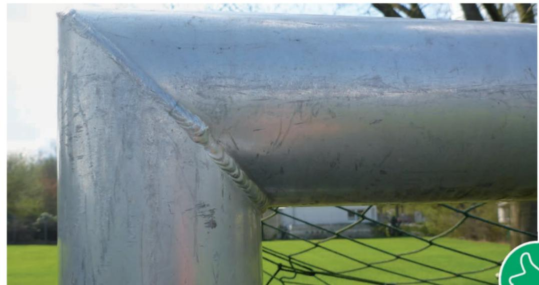
Bild 14: Pfosten und Querlatte haben den gleichen Querschnitt
