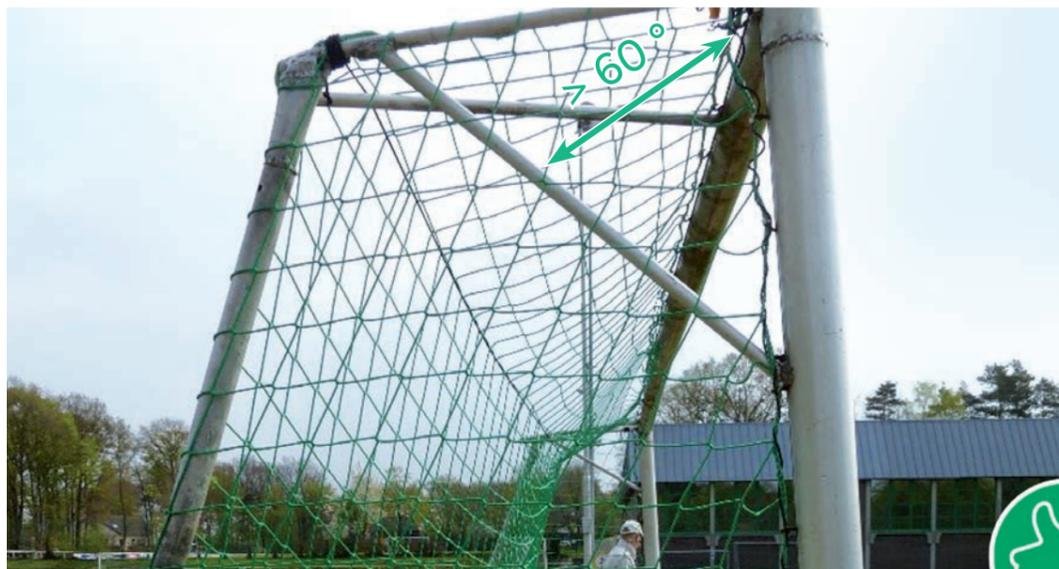
Bild 20: Nach oben geöffnete Winkel müssen  $> 60^\circ$  sein
