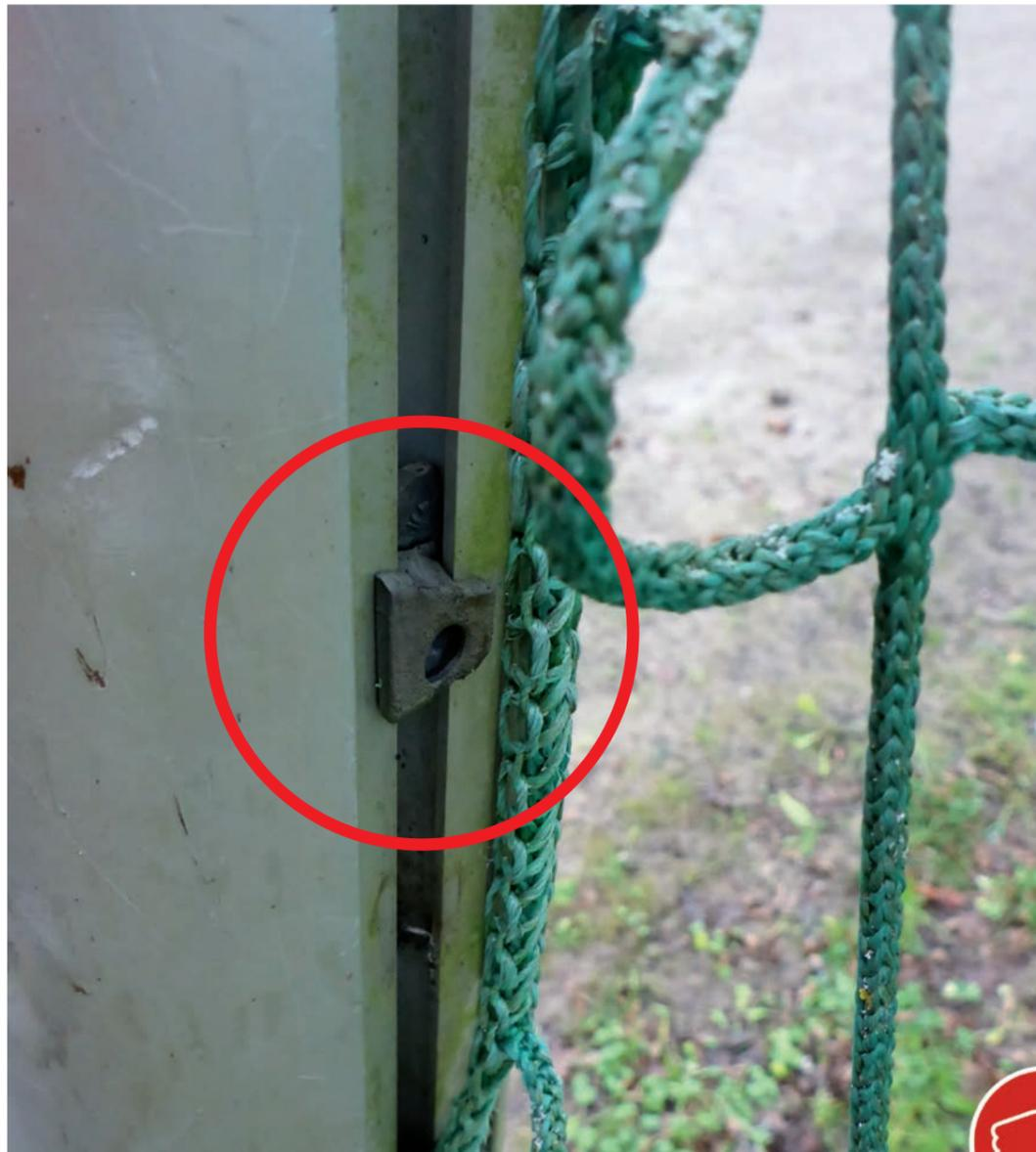
Bild 33: Gebrochene Kunststoffnetzhasen sind auszutauschen.
