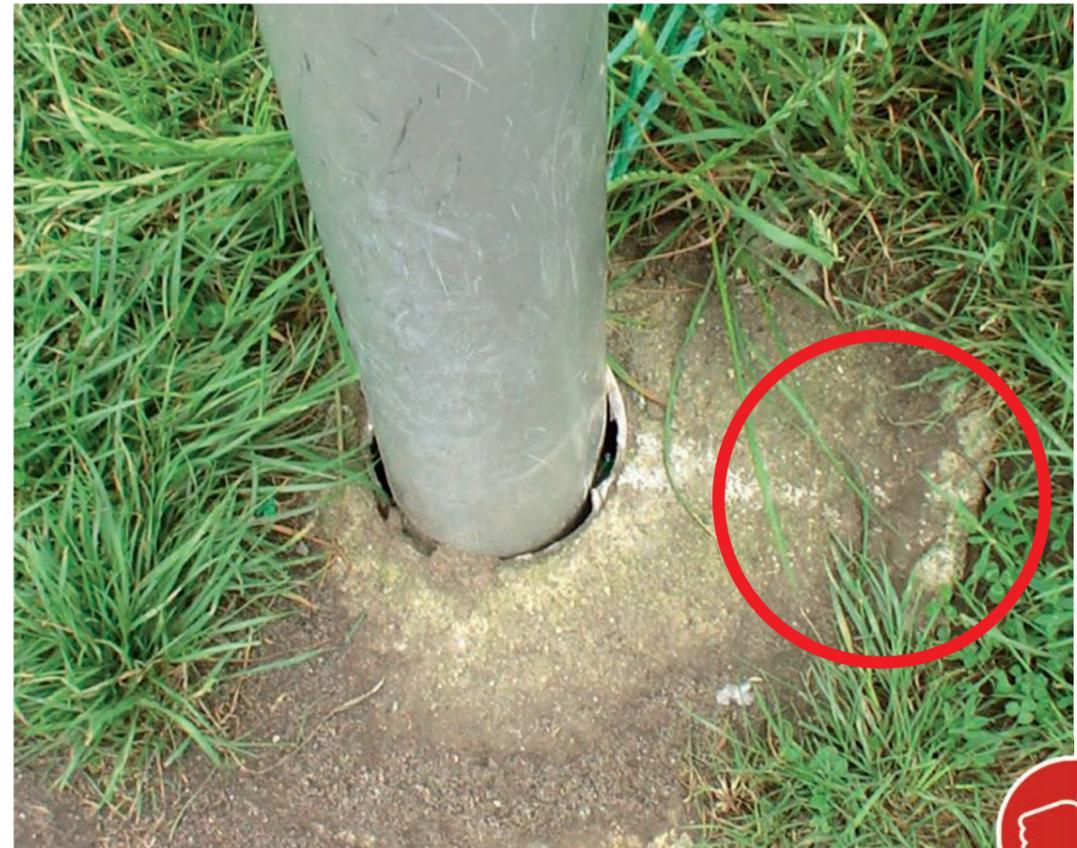
Bild 25: Fundamente sind mind. 4 cm zu überdecken
